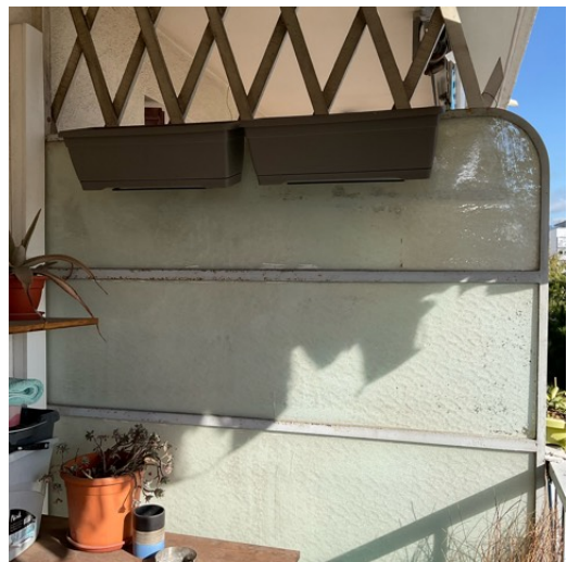
BALCON MUR B SÉPARATION BALCON EN VERRE
