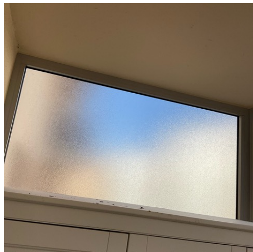
VÉRANDA MUR B FENÊTRE
