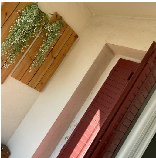
BALCON MUR A FAÇADE
