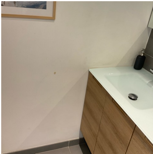
SALLE D'EAU + WC MUR B PEINTURE
