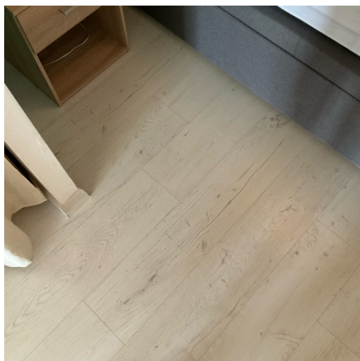
CHAMBRE 1 SOLS PARQUET
