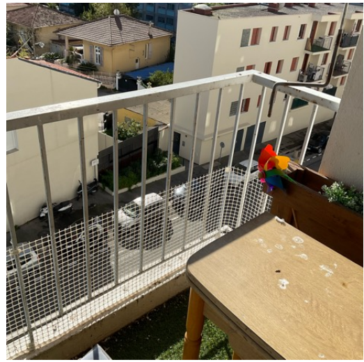
BALCON MUR C GARDE CORPS
