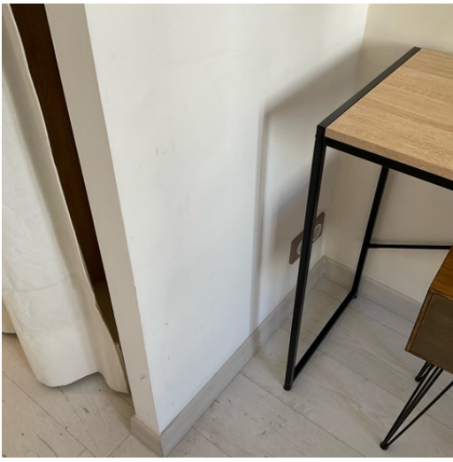
CHAMBRE 2 MUR C PEINTURE
