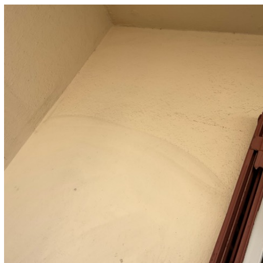
VÉRANDA MUR A FAÇADE
