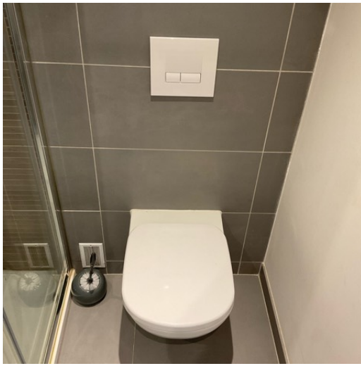
SALLE D'EAU + WC INVENTAIRE WC
