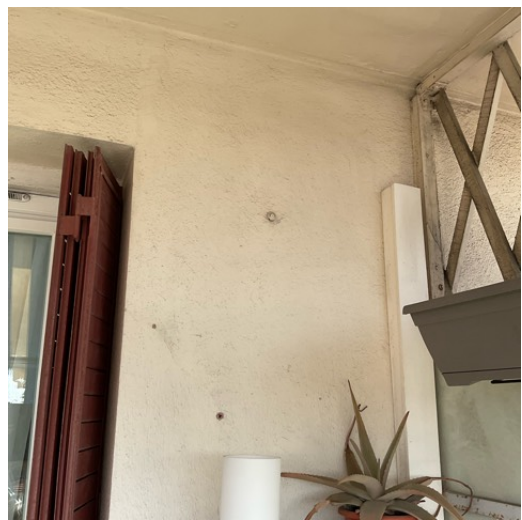
BALCON MUR A FAÇADE
