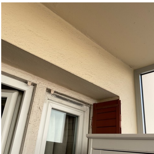
VÉRANDA MUR A FAÇADE
