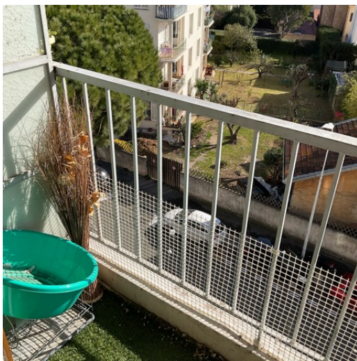
BALCON MUR C GARDE CORPS
