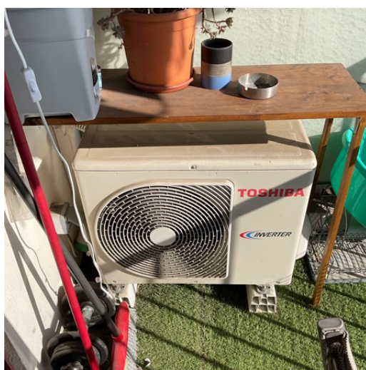
BALCON INVENTAIRE UNITÉ EXTÉRIEURE DE CLIMATISATION
