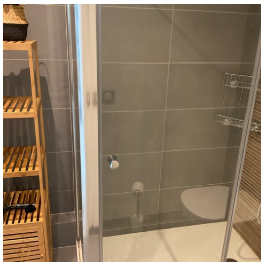
SALLE D'EAU + WC MUR C CARRELAGE
