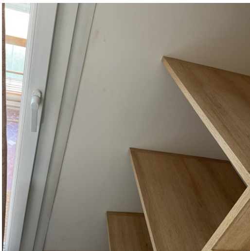
CHAMBRE 1 MUR C PEINTURE
