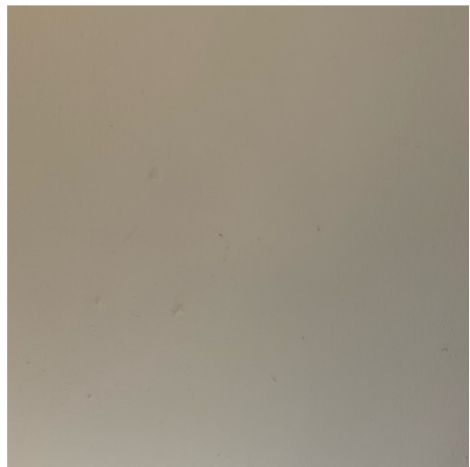
VÉRANDA PLAFOND PEINTURE
