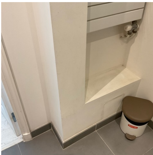
SALLE D'EAU + WC MUR A PEINTURE
