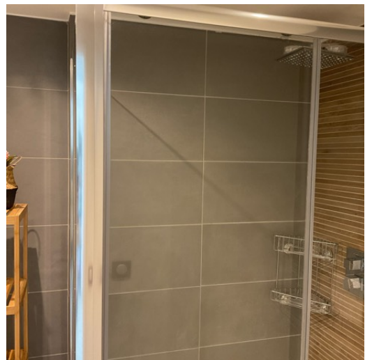
SALLE D'EAU + WC MUR C CARRELAGE
