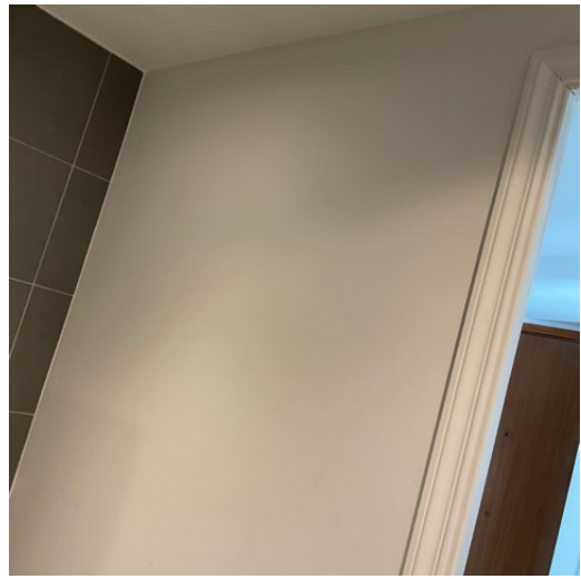
SALLE D'EAU + WC MUR A PEINTURE
