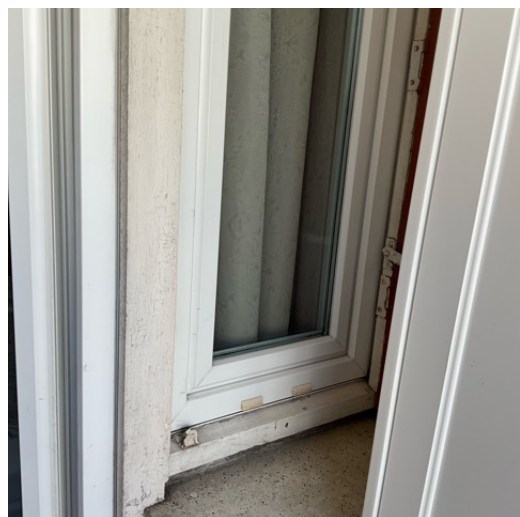
VÉRANDA MUR A FAÇADE
