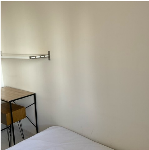
CHAMBRE 2 MUR C PEINTURE
