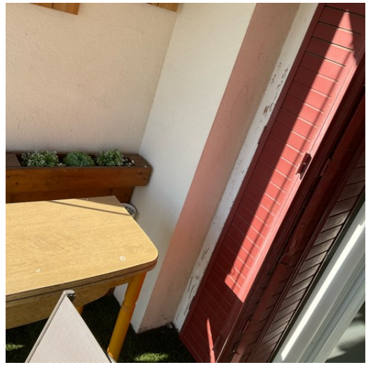
BALCON MUR A FAÇADE
