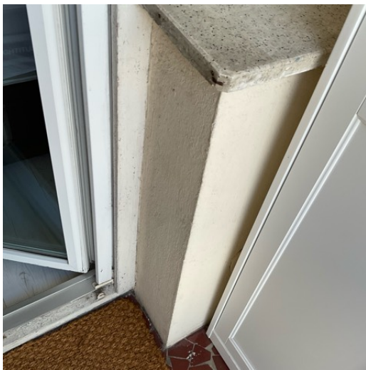
VÉRANDA MUR A FAÇADE
