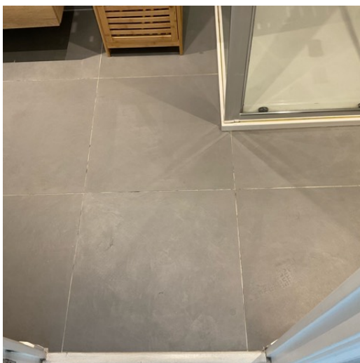
SALLE D'EAU + WC SOLS CARRELAGE
