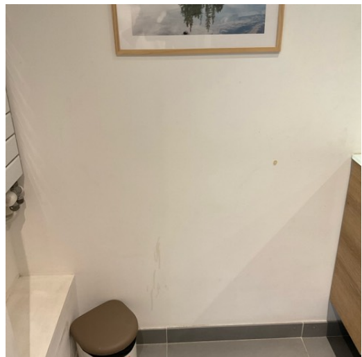
SALLE D'EAU + WC MUR B PEINTURE
