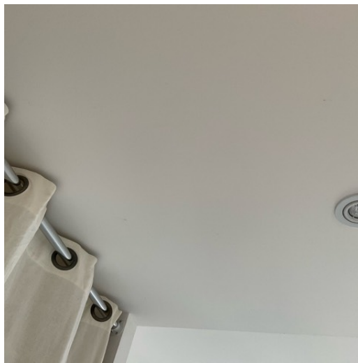
CHAMBRE 2 PLAFOND PEINTURE
