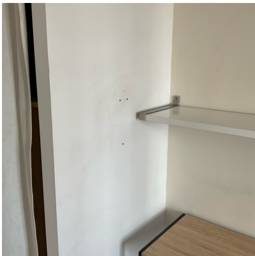
CHAMBRE 2 MUR C PEINTURE
