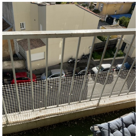
BALCON MUR C GARDE CORPS
