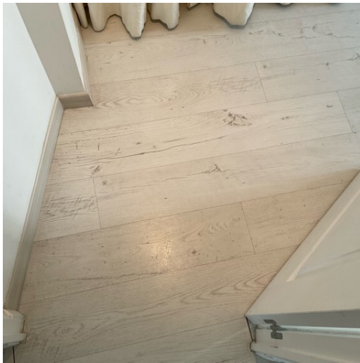
CHAMBRE 2 SOLS PARQUET
