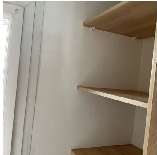
CHAMBRE 1 MUR C PEINTURE
