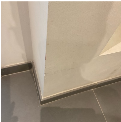
SALLE D'EAU + WC MUR A PEINTURE
